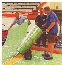
Der Boden wird schon verlegt. Foto: privat
